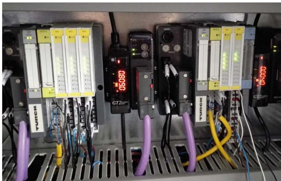
an den Sensoren und Aktoren. IO-Link erlaubt als digitales Protokoll den Einsatz von Standard-Dreidrahtleitungen, die teure Schirmungen und aufwändige Kommissionierung von Kabeln überflüssig machen.
